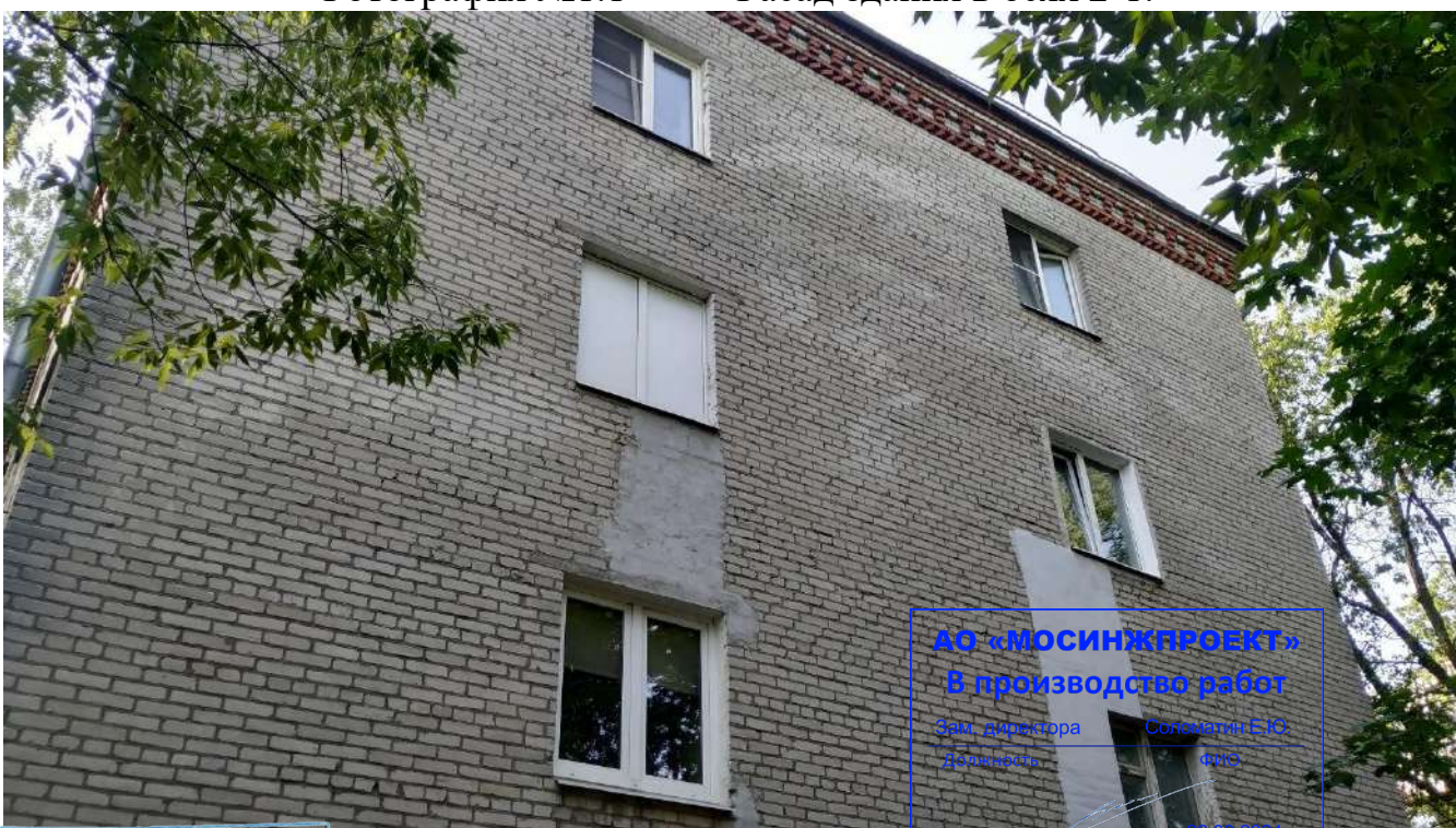
Фотография №1.2 Фасад здания в осях 2-1.
