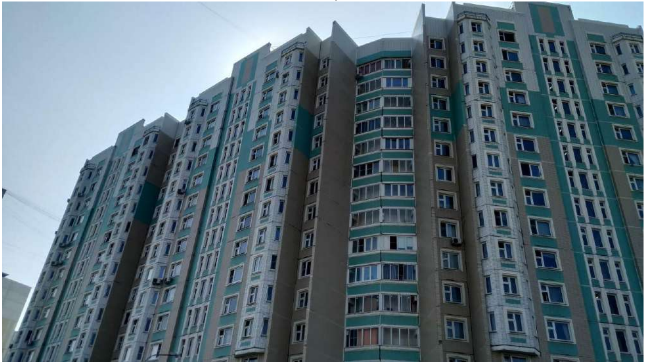
Фотография №5.1 Фасад здания в осях 1-3.
