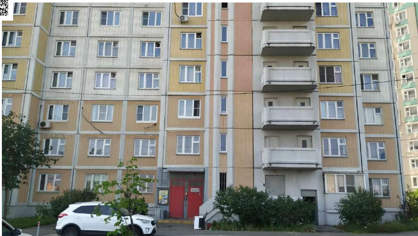
Фотография №6.5 Фасад здания в осях 2-1.
