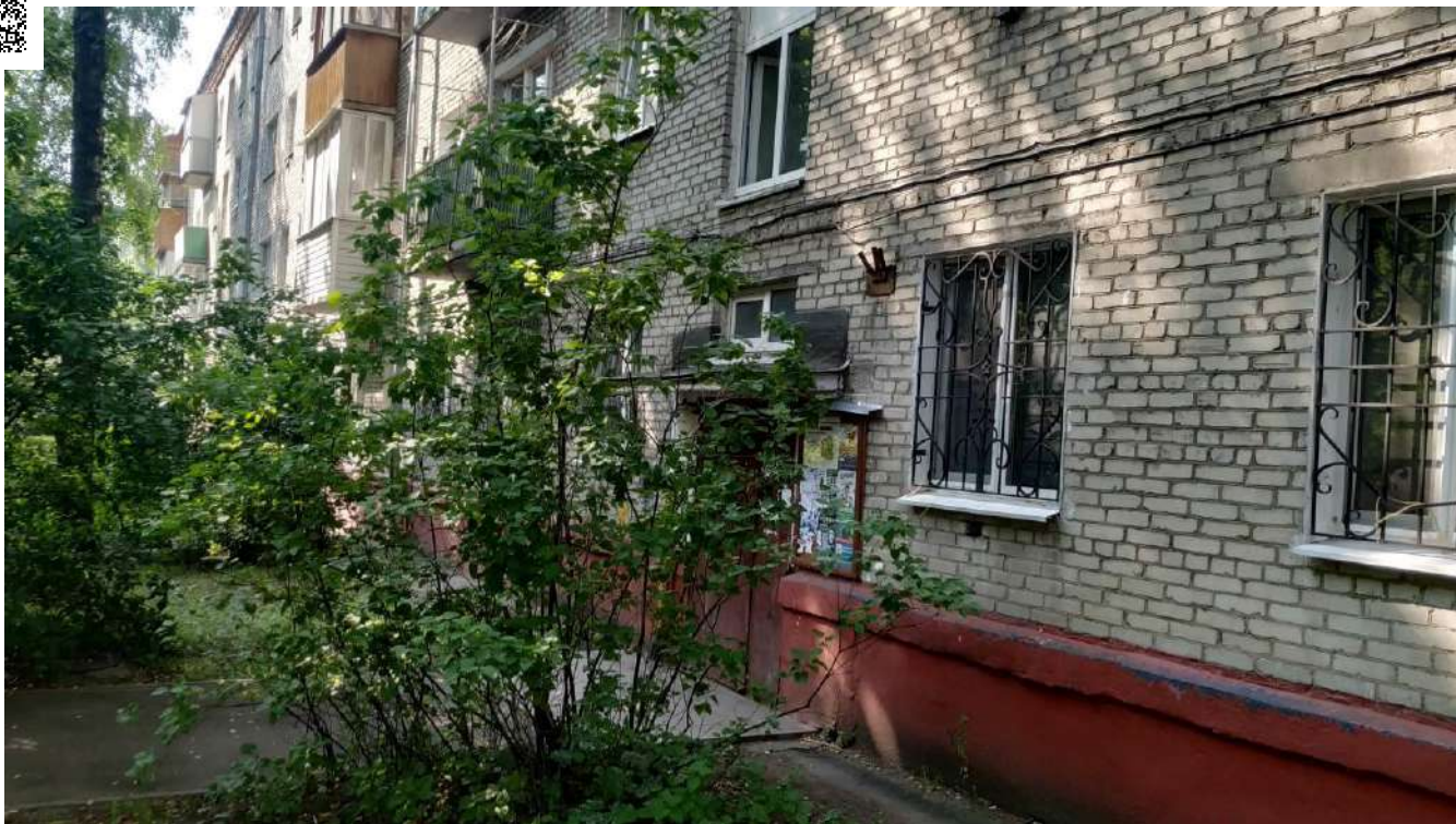
Фотография №1.5 Фасад здания в осях А-Б.
