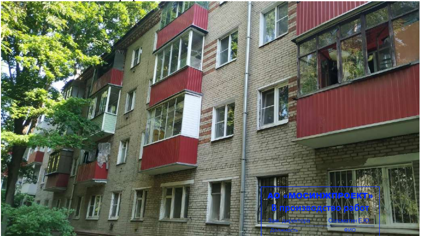
Фотография №3.4 Фасад здания в осях Б-А.
