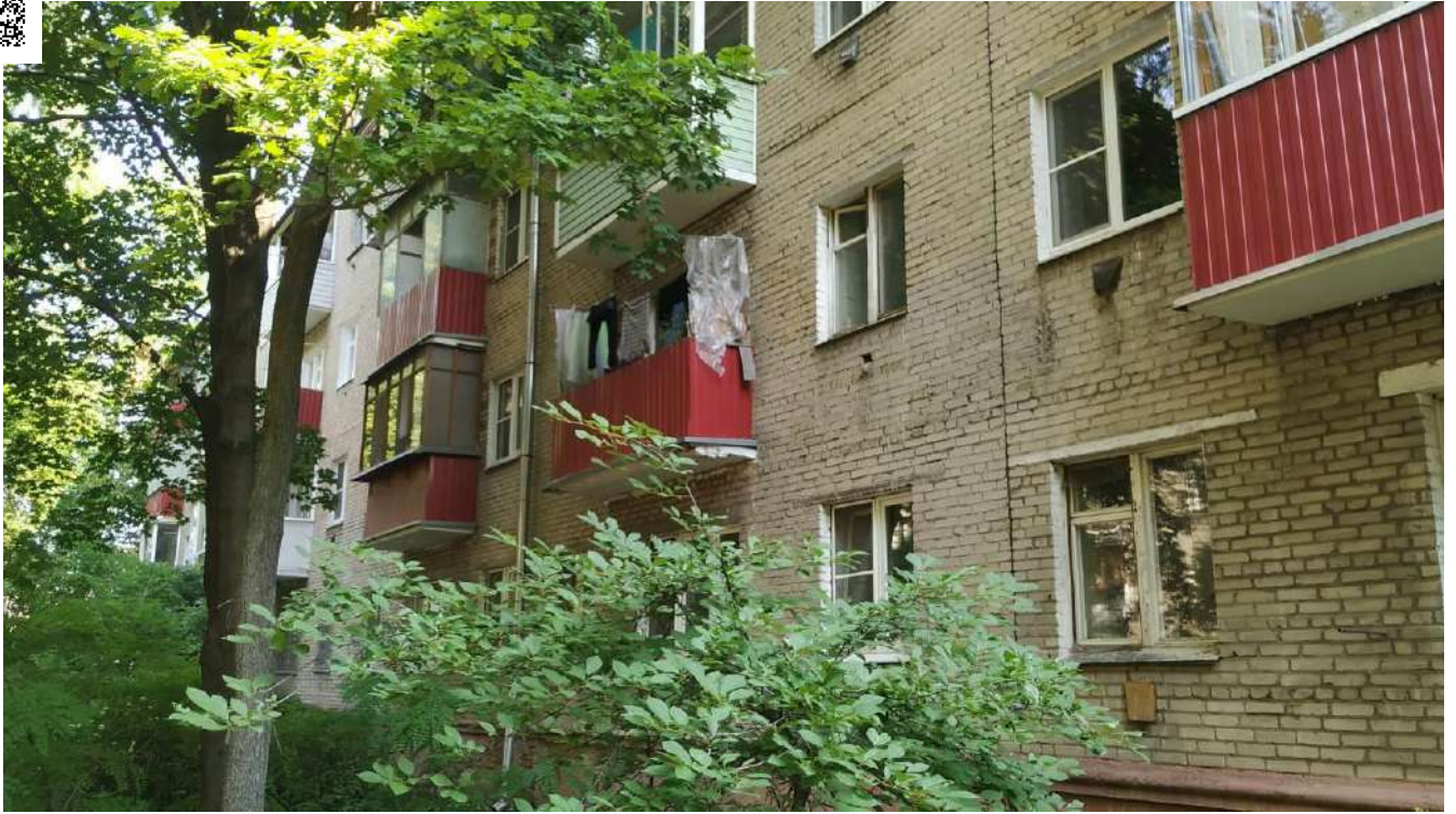
Фотография №3.3 Фасад здания в осях Б-А.
