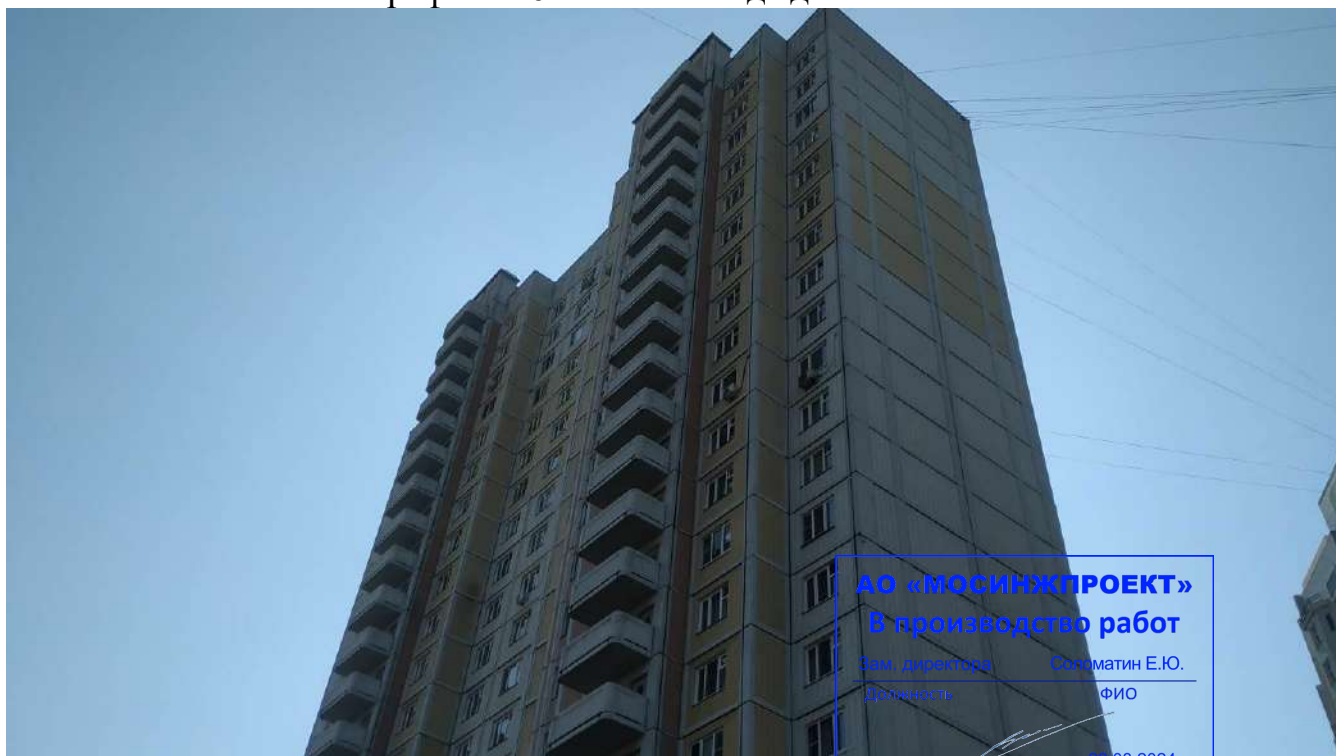
Фотография №6.2 Фасад здания в осях 2-1.
