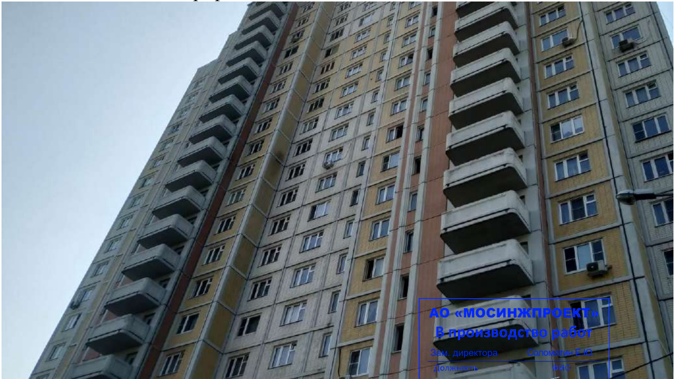
Фотография №6.4 Фасад здания в осях 2-1.
