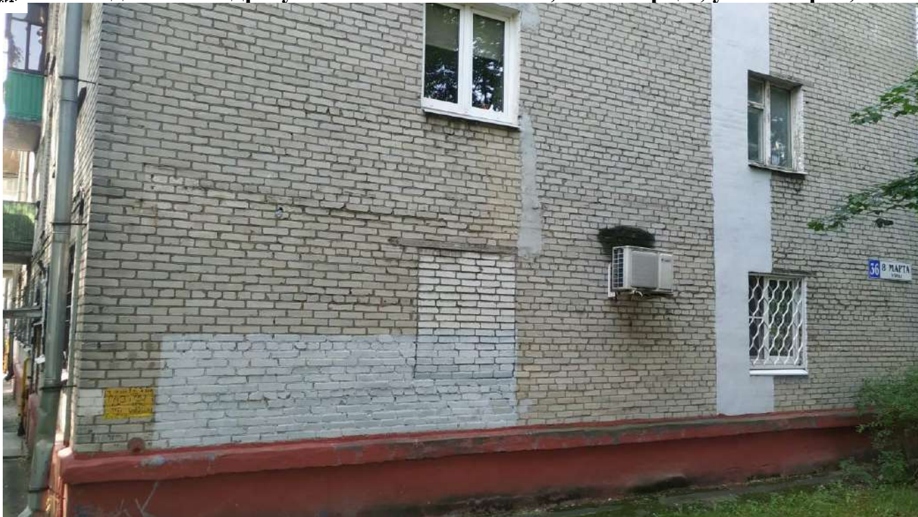
Фотография №1.1 Фасад здания в осях 2-1.
