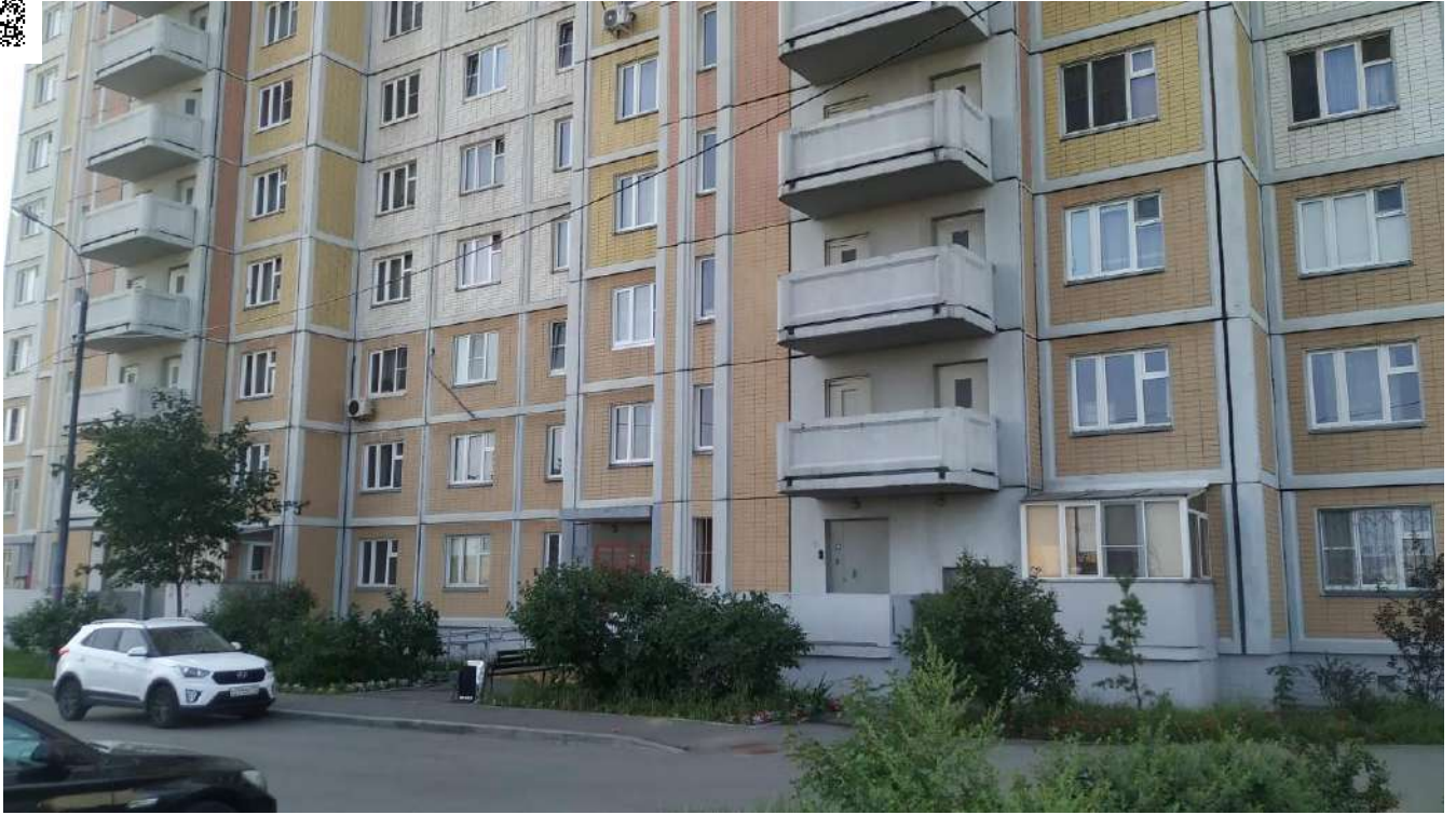
Фотография №6.3 Фасад здания в осях 2-1.
