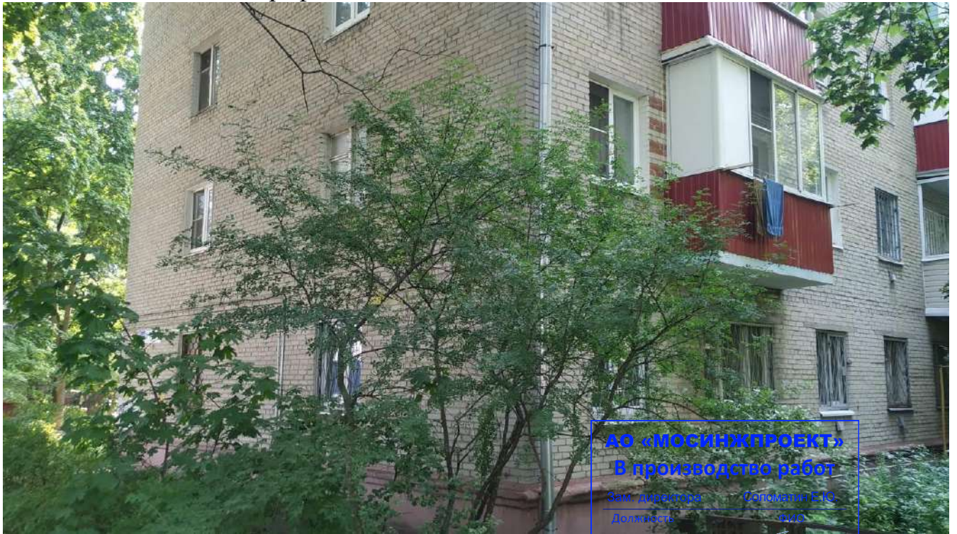
Фотография №3.6 Фасад здания в осях 2-1.
