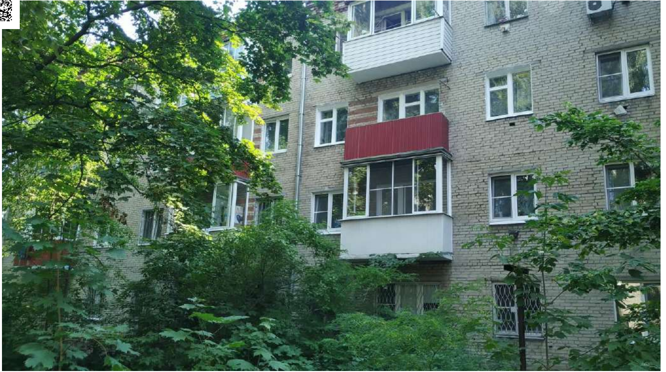
Фотография №3.5 Фасад здания в осях Б-А.
