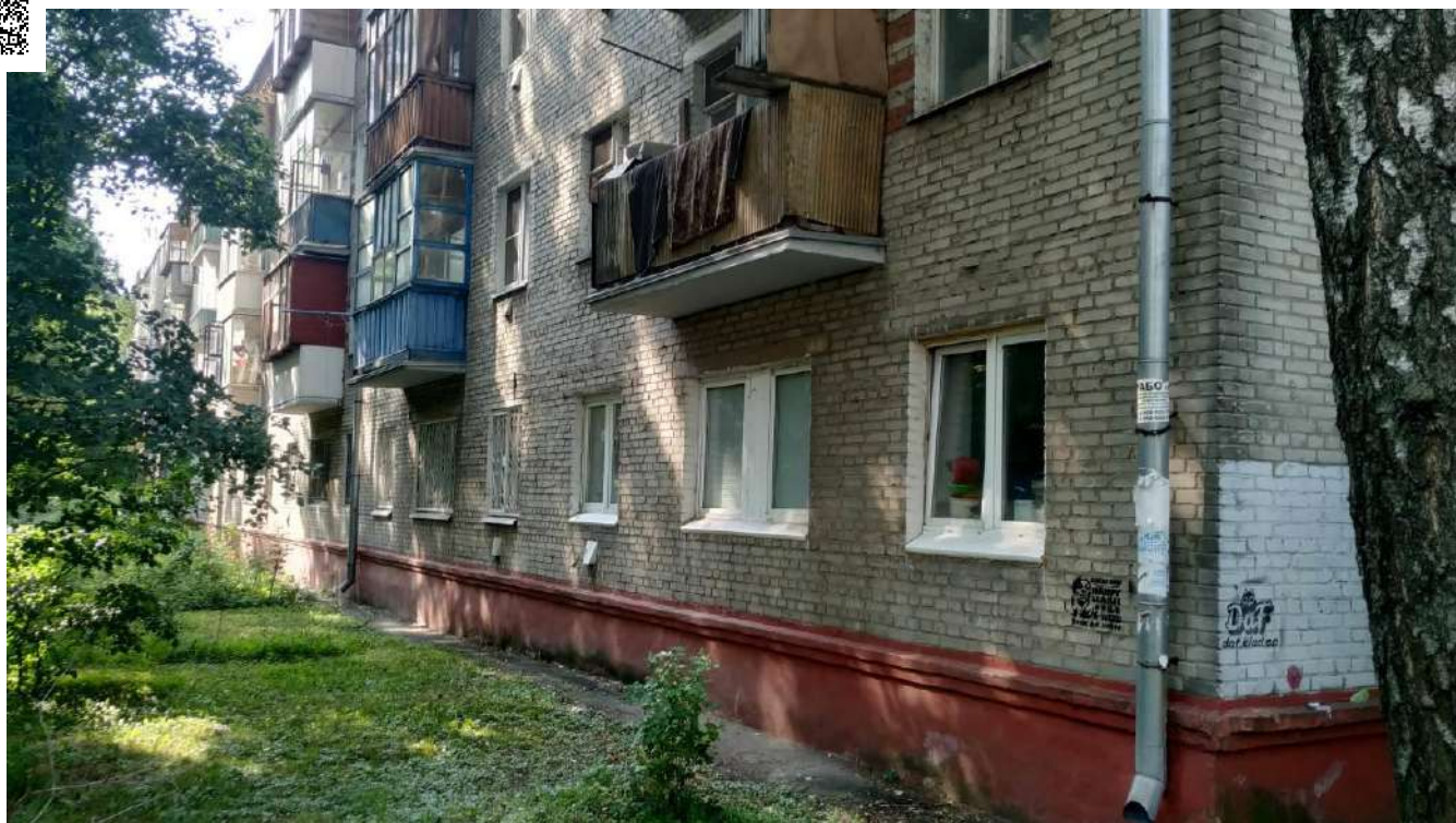
Фотография №2.9 Фасад здания в осях А-Б.
