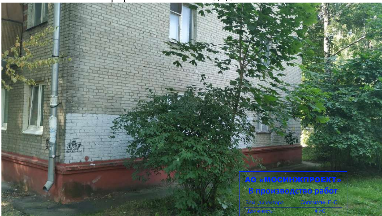
Фотография №2.8 Фасад здания в осях 2-1.
