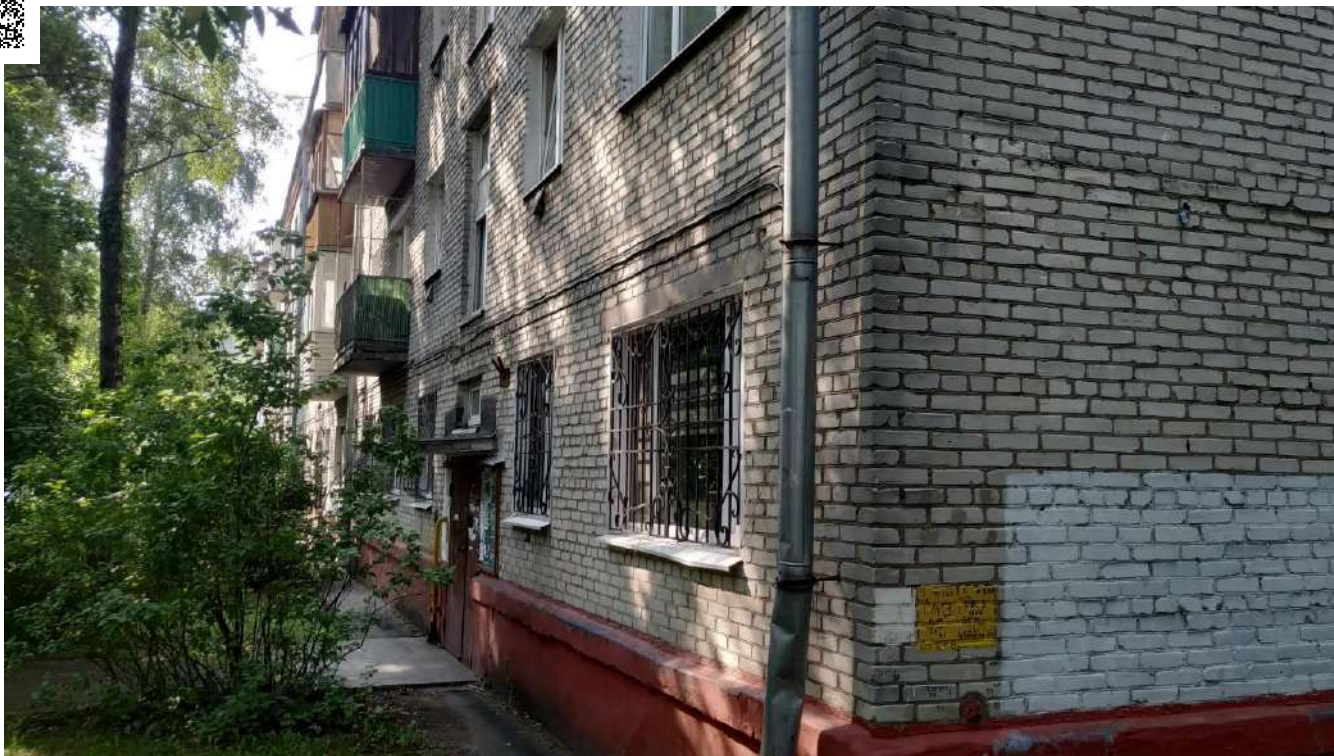
Фотография №1.3 Фасад здания в осях А-Б.
