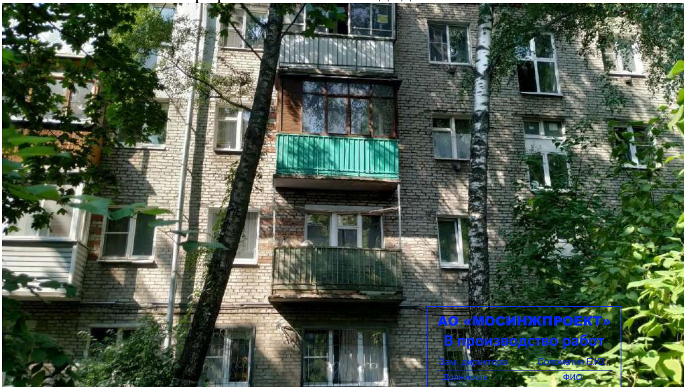
Фотография №1.6 Фасад здания в осях А-Б.
