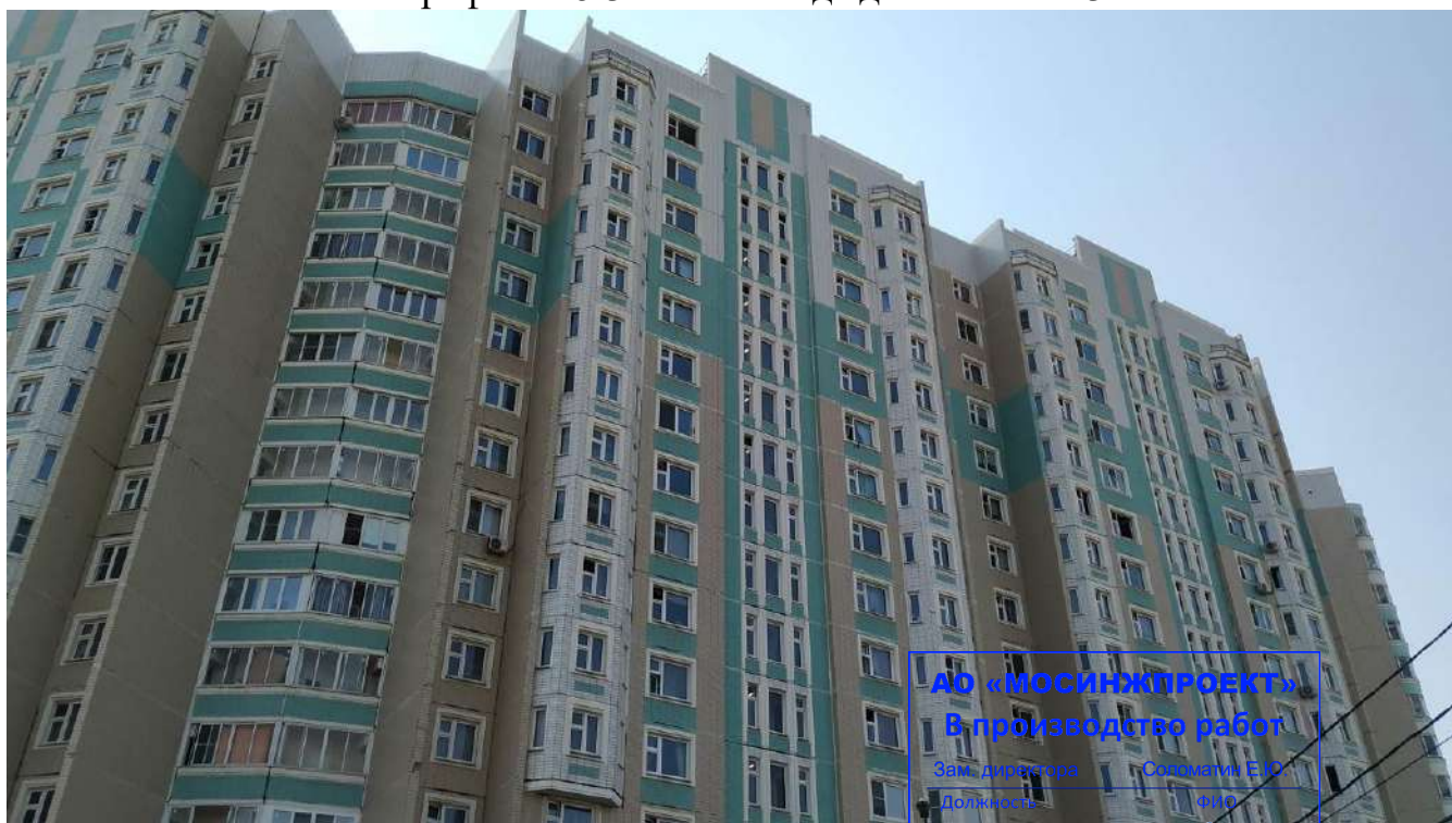
Фотография №5.4 Фасад здания в осях 3-4.
