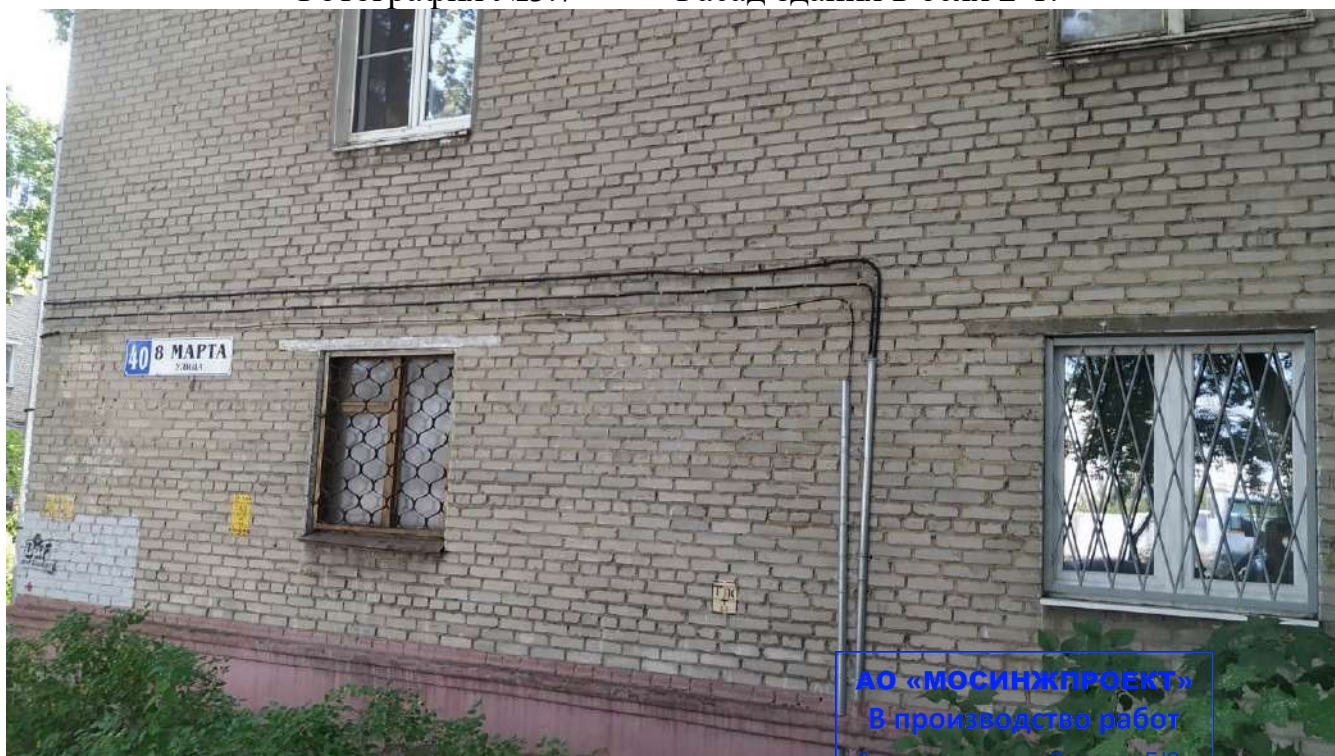
Фотография №3.8 Фасад здания в осях 2-1.
