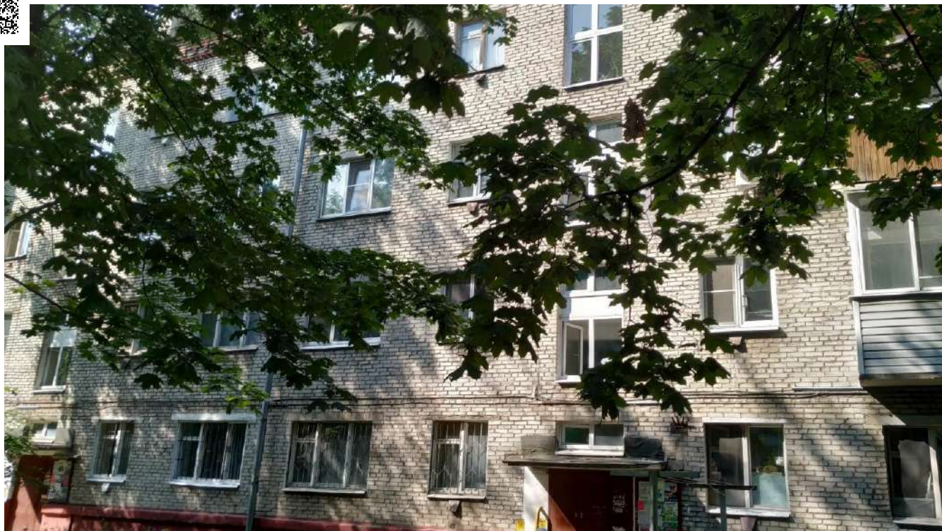
Фотография №1.7 Фасад здания в осях А-Б.
