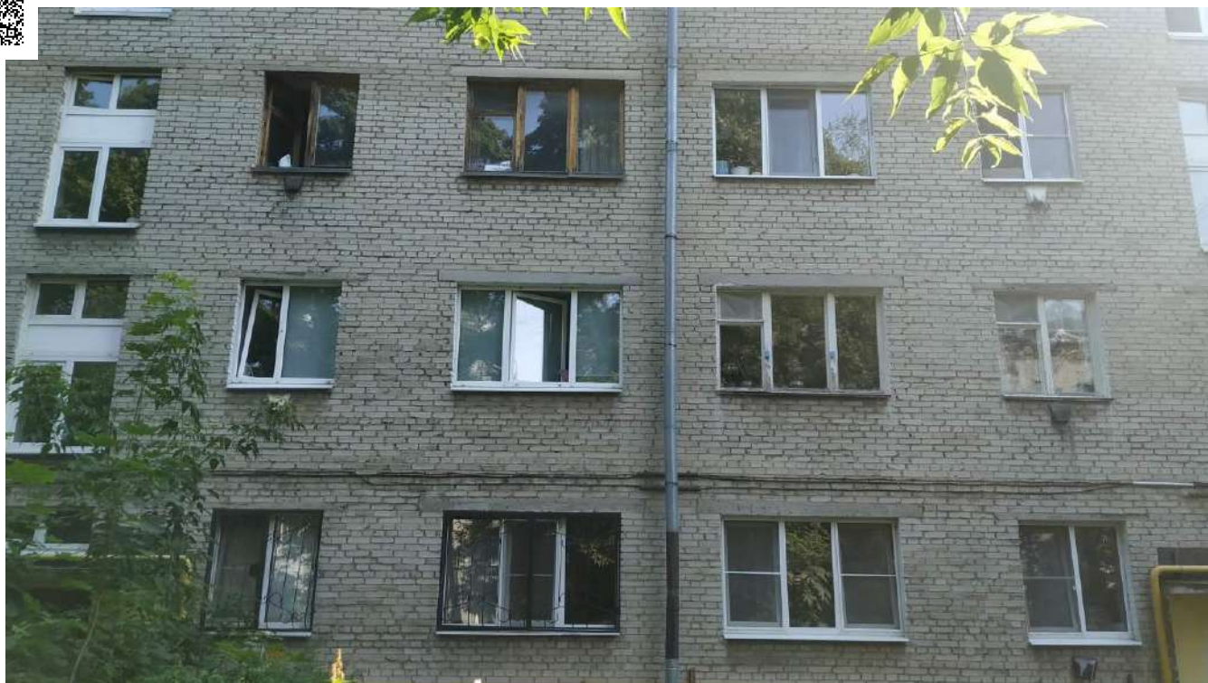
Фотография №2.5 Фасад здания в осях Б-А.
