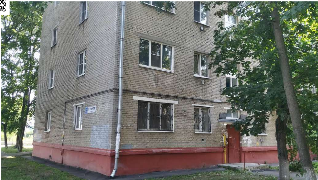
Фотография №4.3 Фасад здания в осях 2-1.
