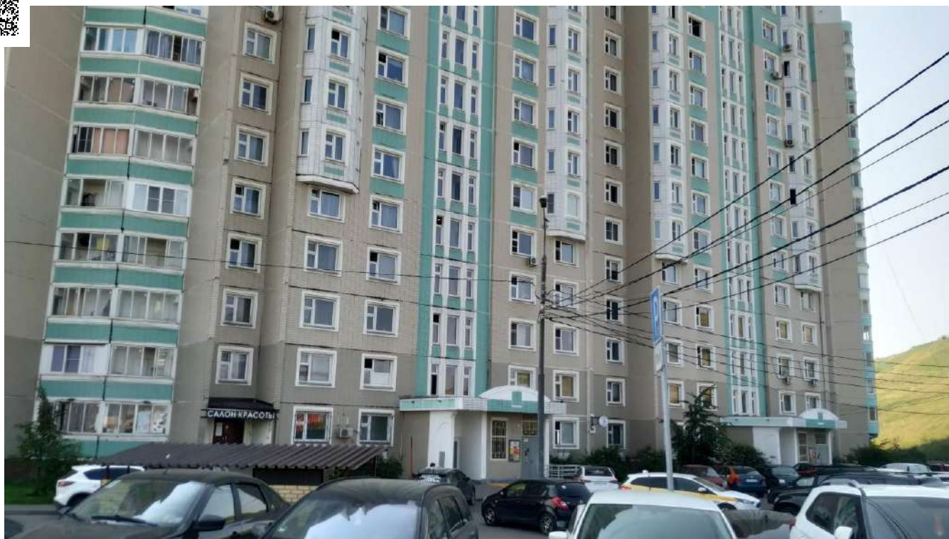
Фотография №5.3 Фасад здания в осях 3-4.
