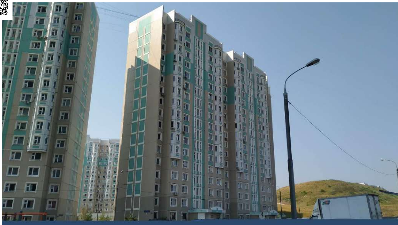
Фотография №5.5 Фасад здания в осях 1-2.
