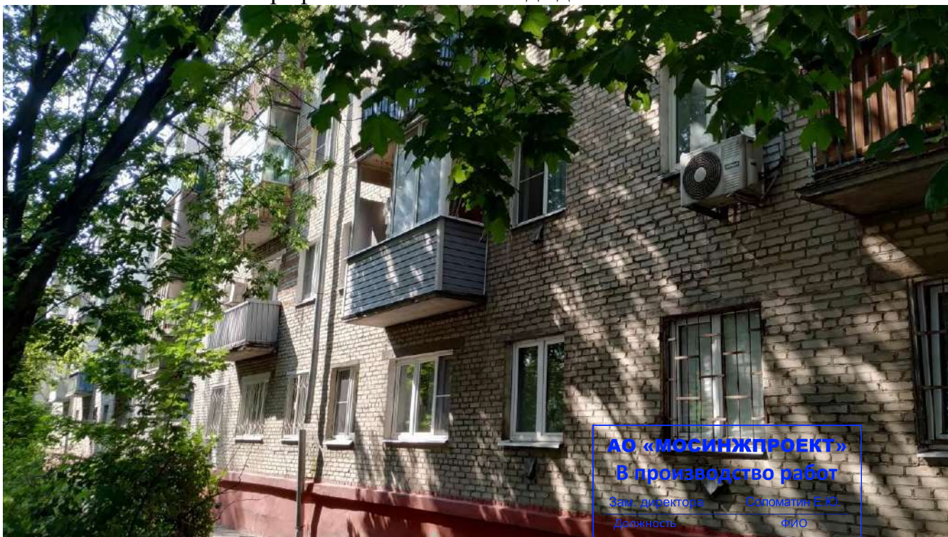
Фотография №4.6 Фасад здания в осях А-Б.
