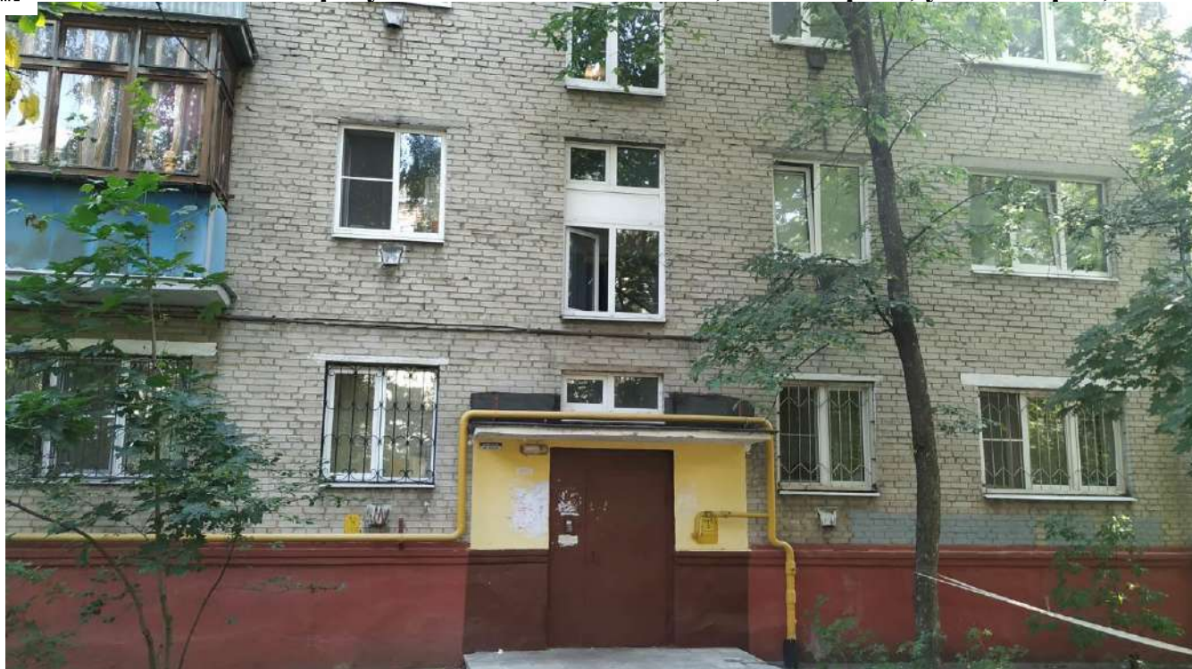
Фотография №2.1 Фасад здания в осях Б-А.
