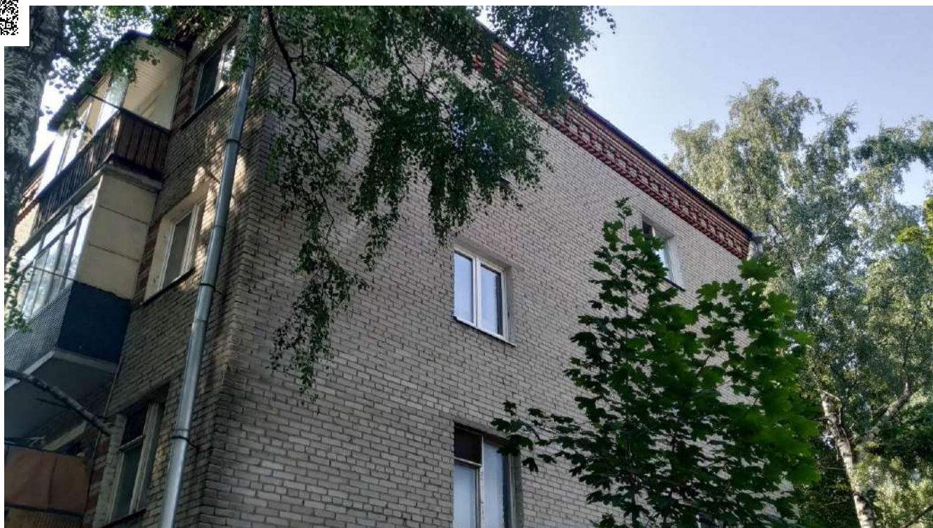
Фотография №2.7 Фасад здания в осях 2-1.
