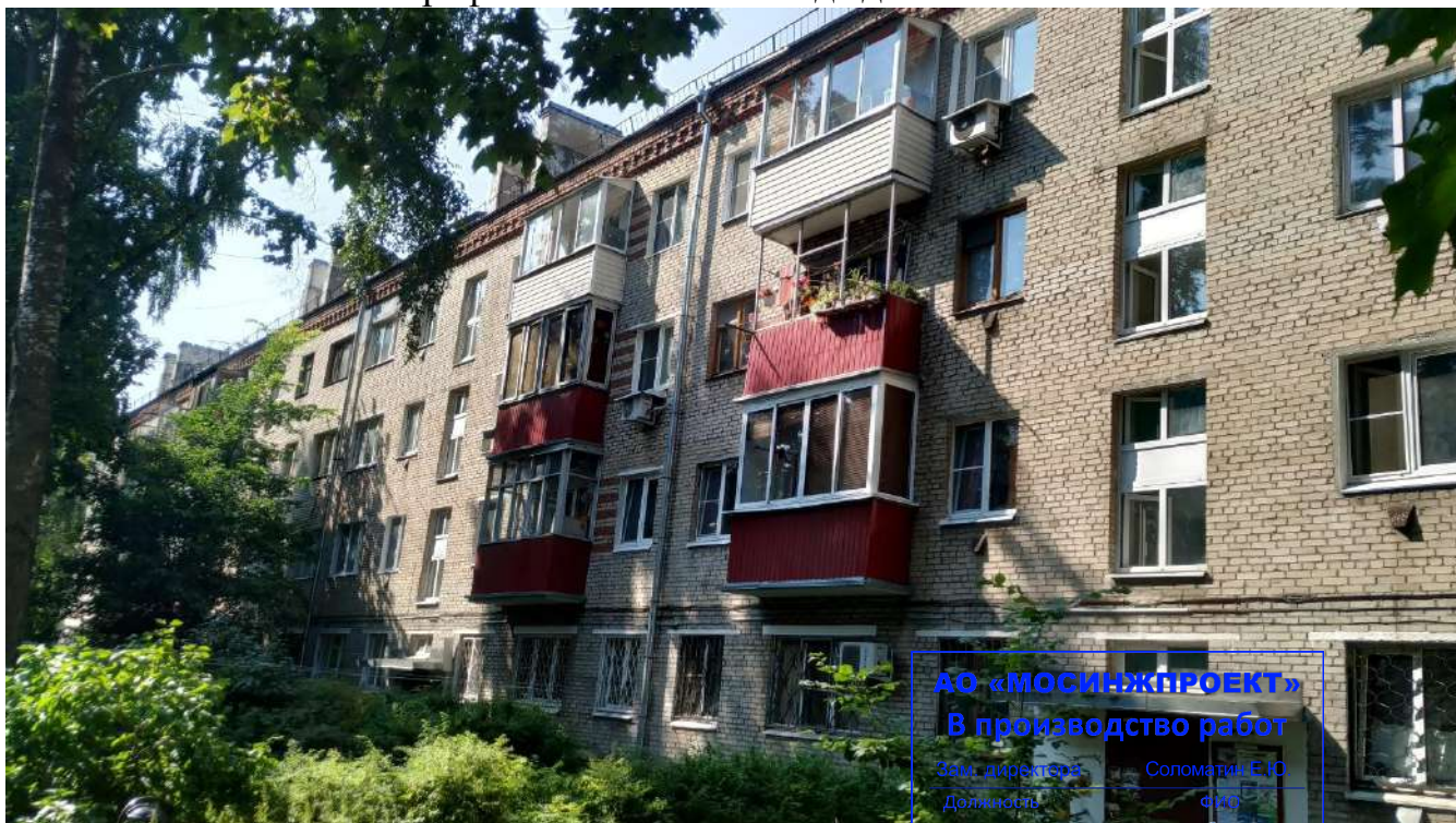
Фотография №3.10 Фасад здания в осях А-Б.
