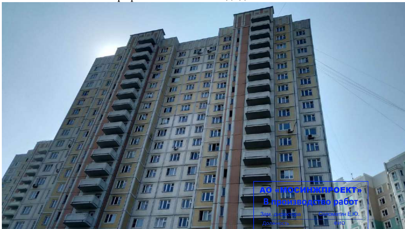
Фотография №6.6 Фасад здания в осях 2-1.
