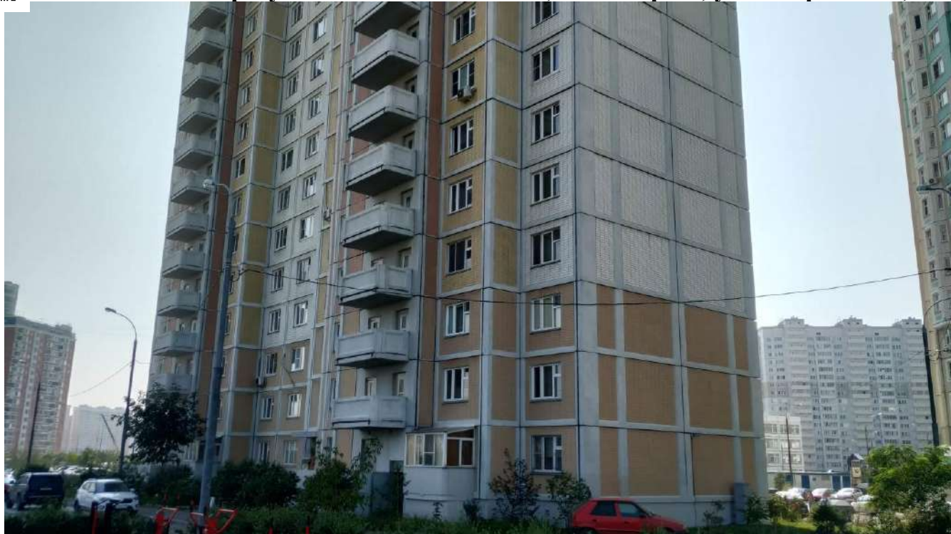
Фотография №6.1 Фасад здания в осях 2-1.
