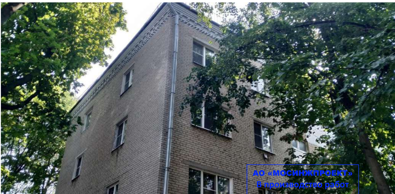
Фотография №4.4 Фасад здания в осях 2-1.
