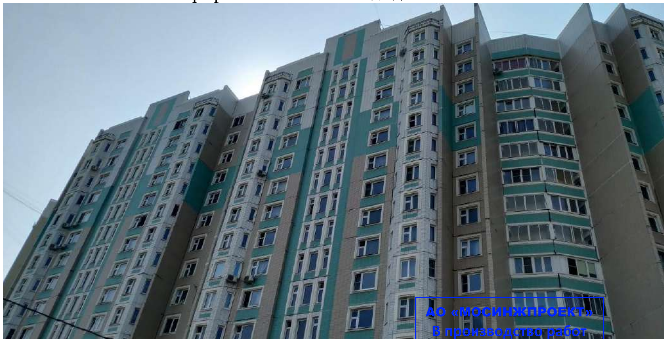
Фотография №5.8 Фасад здания в осях 1-3.
