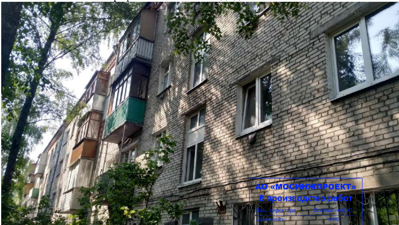
Фотография №1.4 Фасад здания в осях А-Б.
