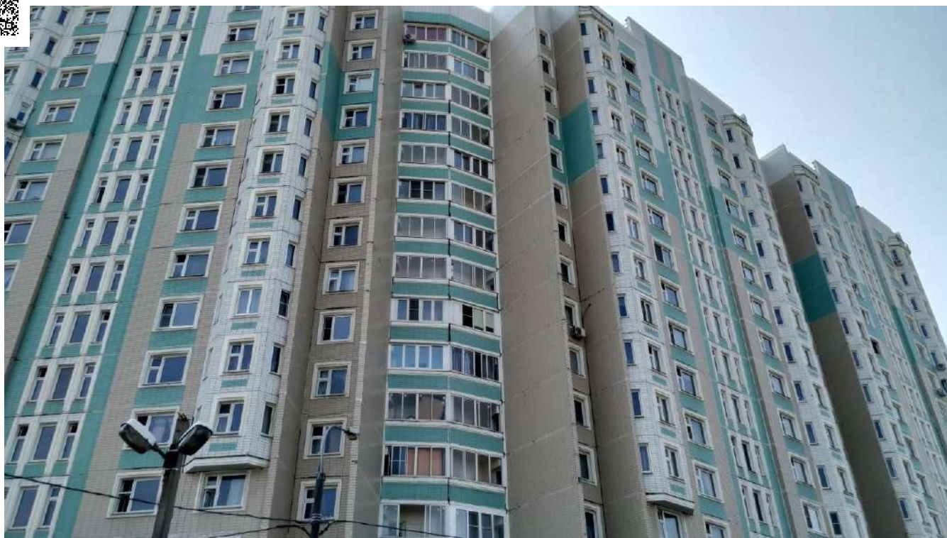
Фотография №5.7 Фасад здания в осях 2-4.
