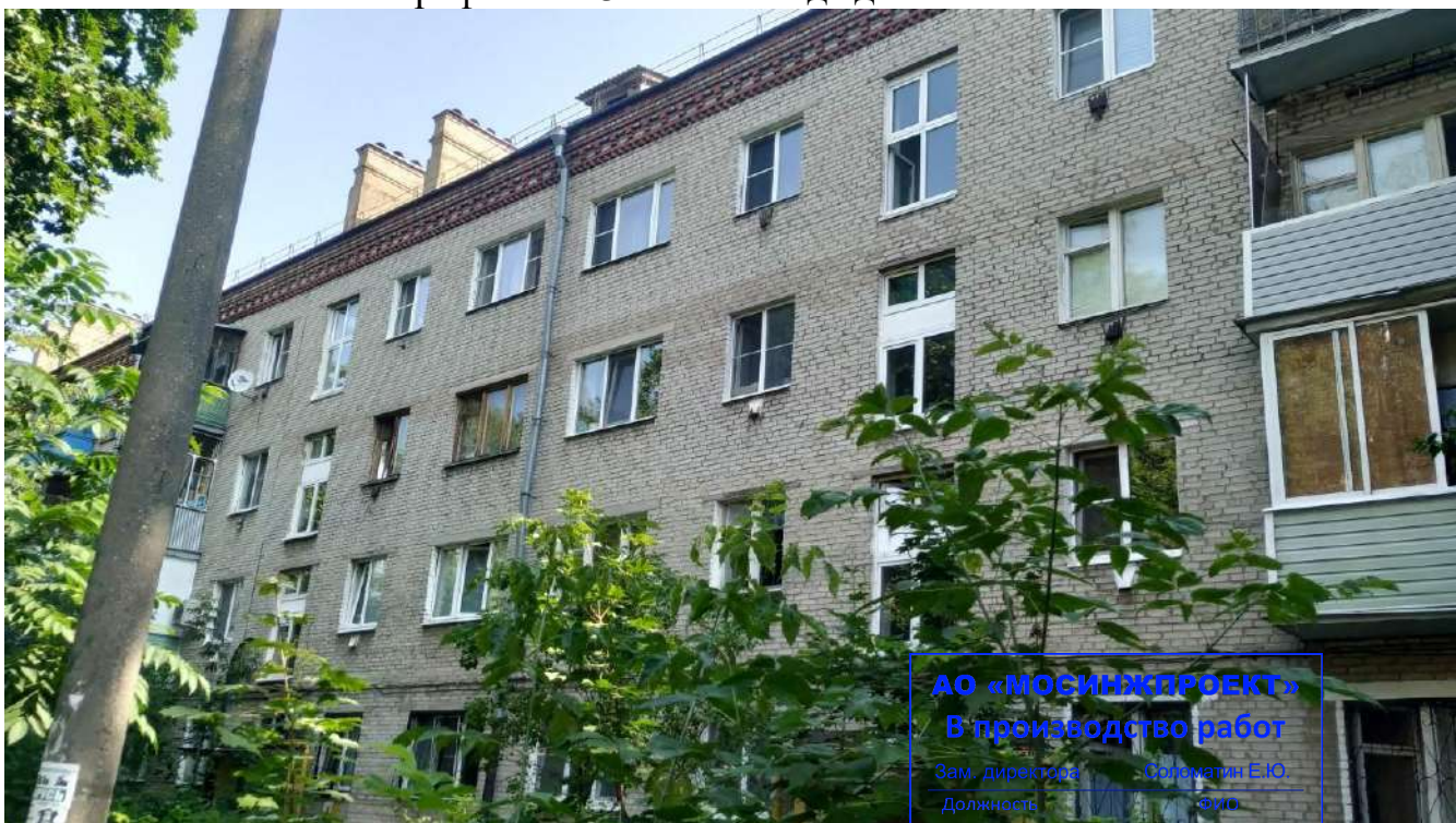
Фотография №2.4 Фасад здания в осях Б-А.
