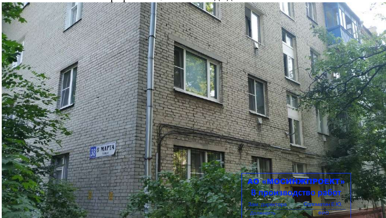
Фотография №2.6 Фасад здания в осях Б-А.
