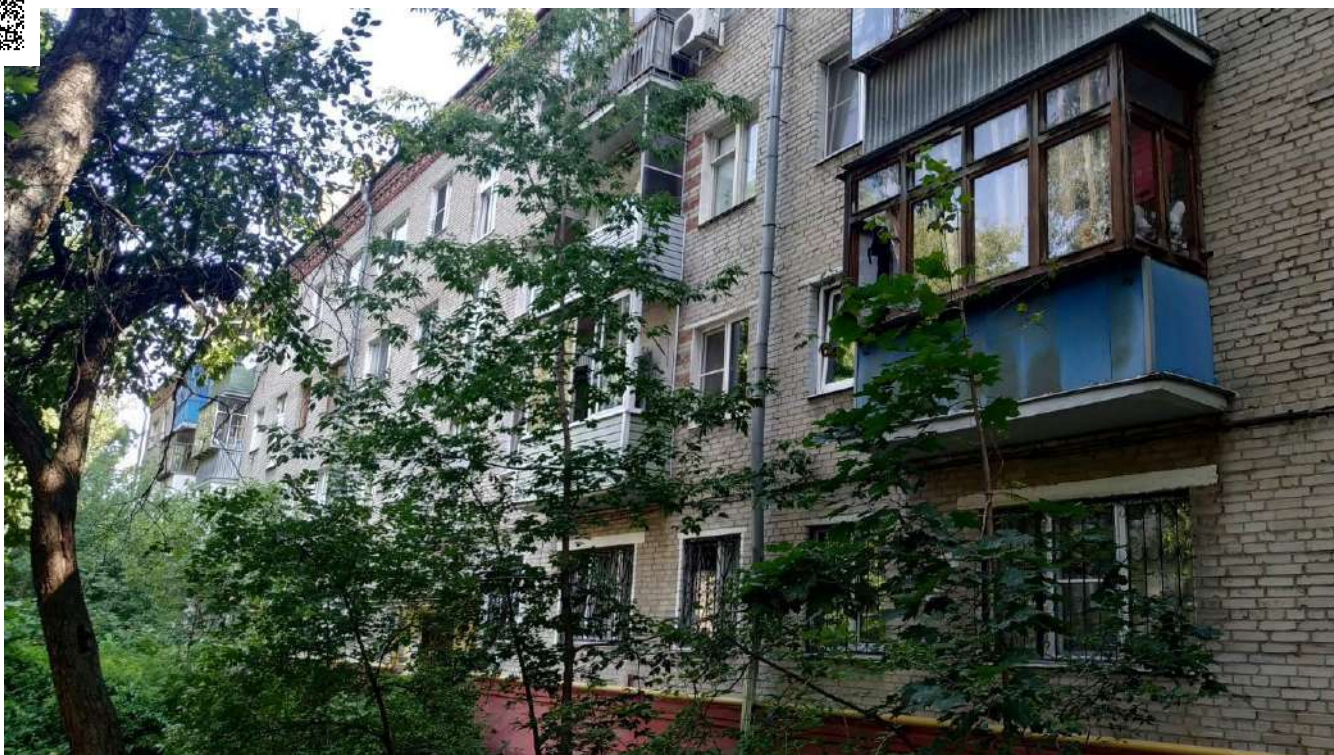
Фотография №2.3 Фасад здания в осях Б-А.
